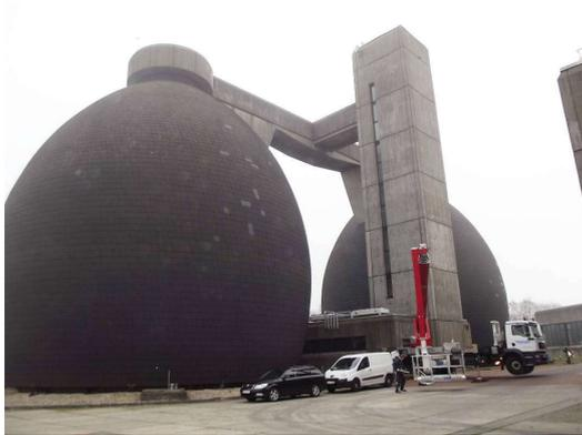
Abbildung 1: Untersuchung der Verbindungsbrücke zwischen 2 Faultürmen mittels Hubsteiger
